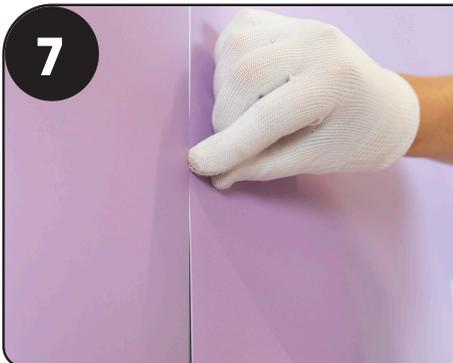
7 Die Magnete sind befestigt, jetzt können Sie das Plattenmaterial an dem Rahmen anbringen. Fangen Sie auf der linken Seite an. Es ist wichtig, dass Sie vorsichtig arbeiten, weil das PVC-Material sehr empfindlich ist. Wir empfehlen Ihnen bei der Montage des Druckes weiche Handschuhe zu tragen
